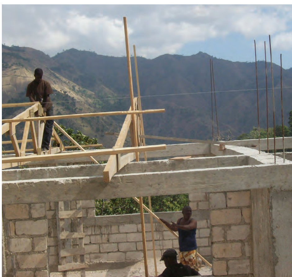
Construction d'une école en Haïti
